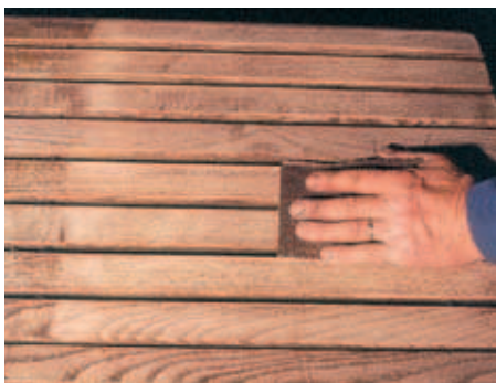
Pulire la superficie ed irruvidirla leggermente Oberfläche reinigen und leicht aufrauen Nettoyer et raboter légèrement la surface des bois
